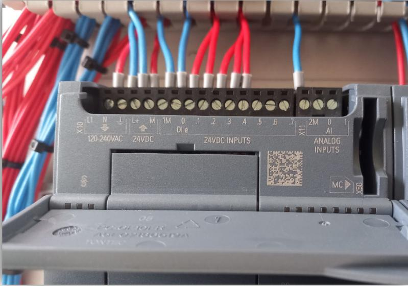
Figura 66 - Imagem da eletrificação do PLC
